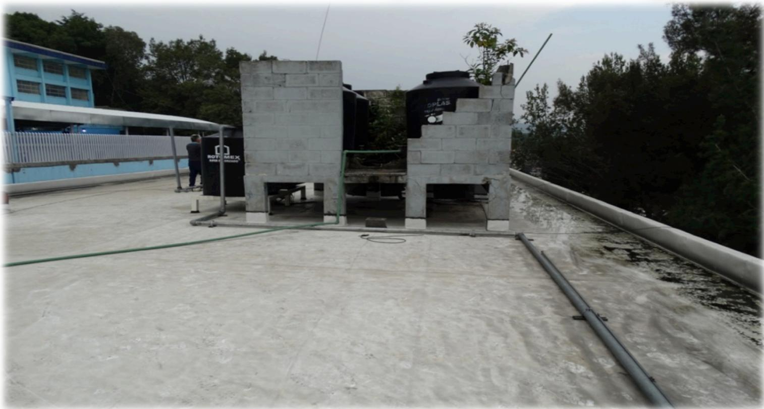
El sistema se conduce por tubería de fierro galvanizado para su almacenamiento.
