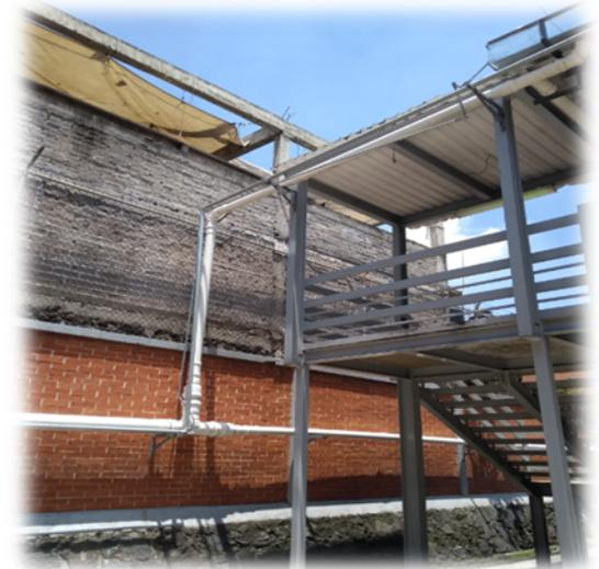
Se conduce el agua pluvial por medio de tubería de PVC y/o lamina galvanizada con pendiente.
