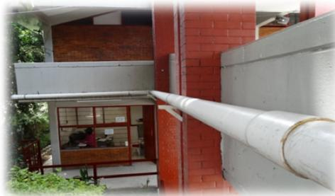
Se conduce el agua pluvial por medio de tubería de PVC y/o lámina galvanizada con pendiente, en esta etapa se utilizaron reducciones que se observan para concentrar las b.a.p. y canalizarlas a la cisterna de concreto armado.
