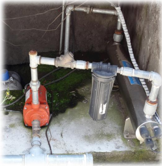
En el momento que el nivel electrónico activa el sistema de bombeo entra en marcha el sistema de purificación, éste se compone de filtros y luz ultravioleta.
