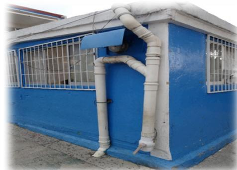
Válvula para desfogar las primeras lluvias, se abre la válvula de color negro y se cierra la válvula del sedimentador de color verde.
