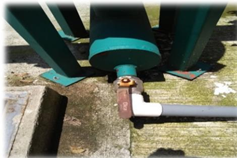
Al termino de las primeras lluvias de cierra la válvula en color negro y se abre la válvula en color verde del sedimentador: este funciona mediante la fuerza centrífuga de la corriente de agua pluvial, los lodos generados se van al sistema de drenaje.
