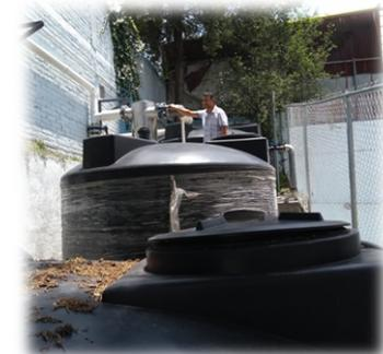
El agua pluvial se combina con el clorador y se almacena en tinacos de 5000L.
