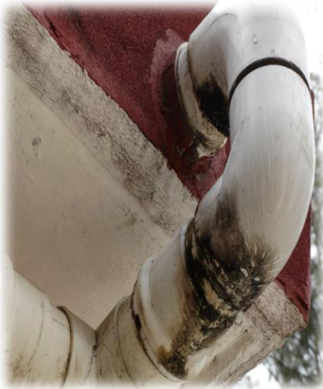
Se conduce el agua pluvial por medio de tubería de PVC y/o lamina galvanizada con pendiente.
