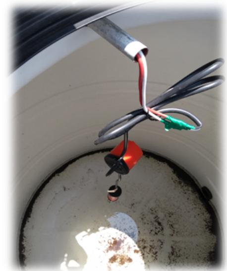
Se instalaron electro niveles en las 3 etapas: estos dispositivos se detectan cuando el nivel de agua es bajo para hacer funcionar el sistema de bombeo
